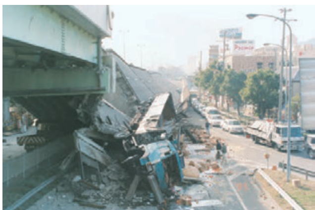
国道43号線の崩壊 (阪神・淡路大震災・神戸市)
